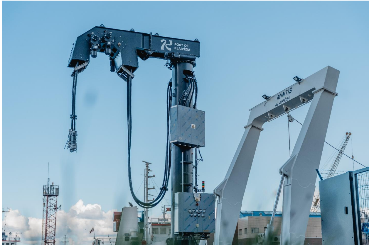
1 pav.. Elektros tiekimo nuo kranto stotis (OPS) RO-RO laivams
